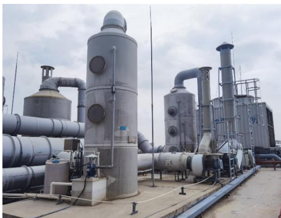
BOE 废气碱液喷淋塔
