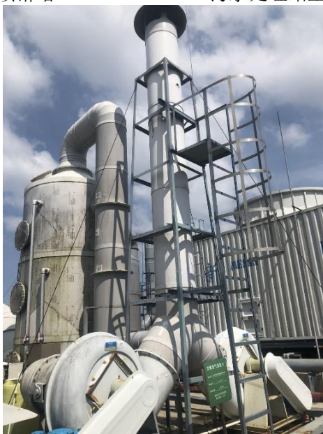
PECVD 废气碱液喷淋塔
