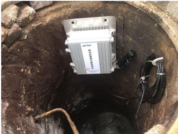
污水外排口 pH、电导率在线监测设备
