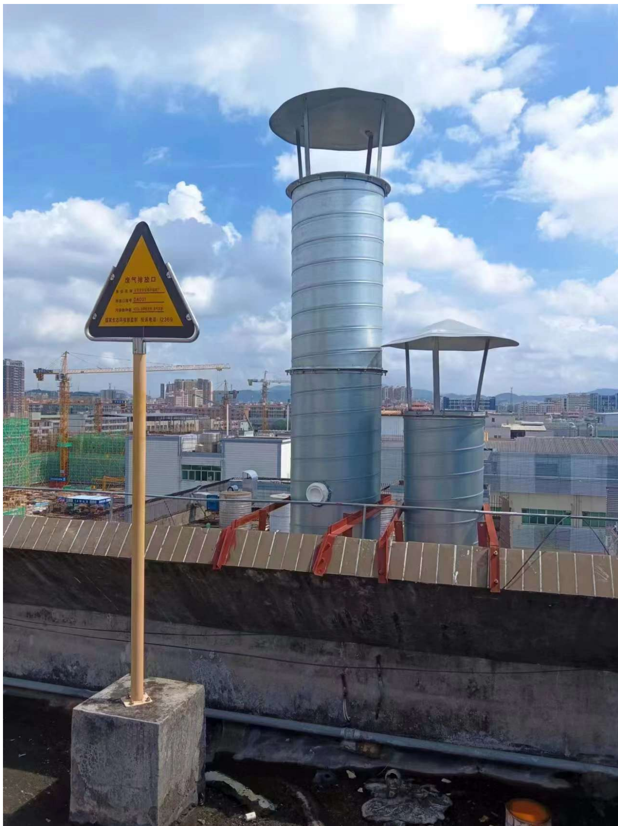
附图六：注塑、点胶、烘烤废气处理设施
