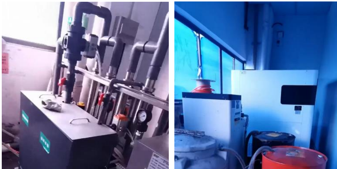
图 3-2 废切削液预处理系统现场照片
