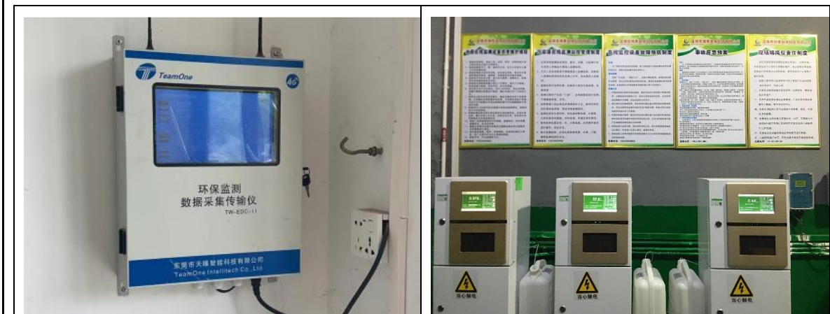
全过程在线监控、废水排口在线监测
