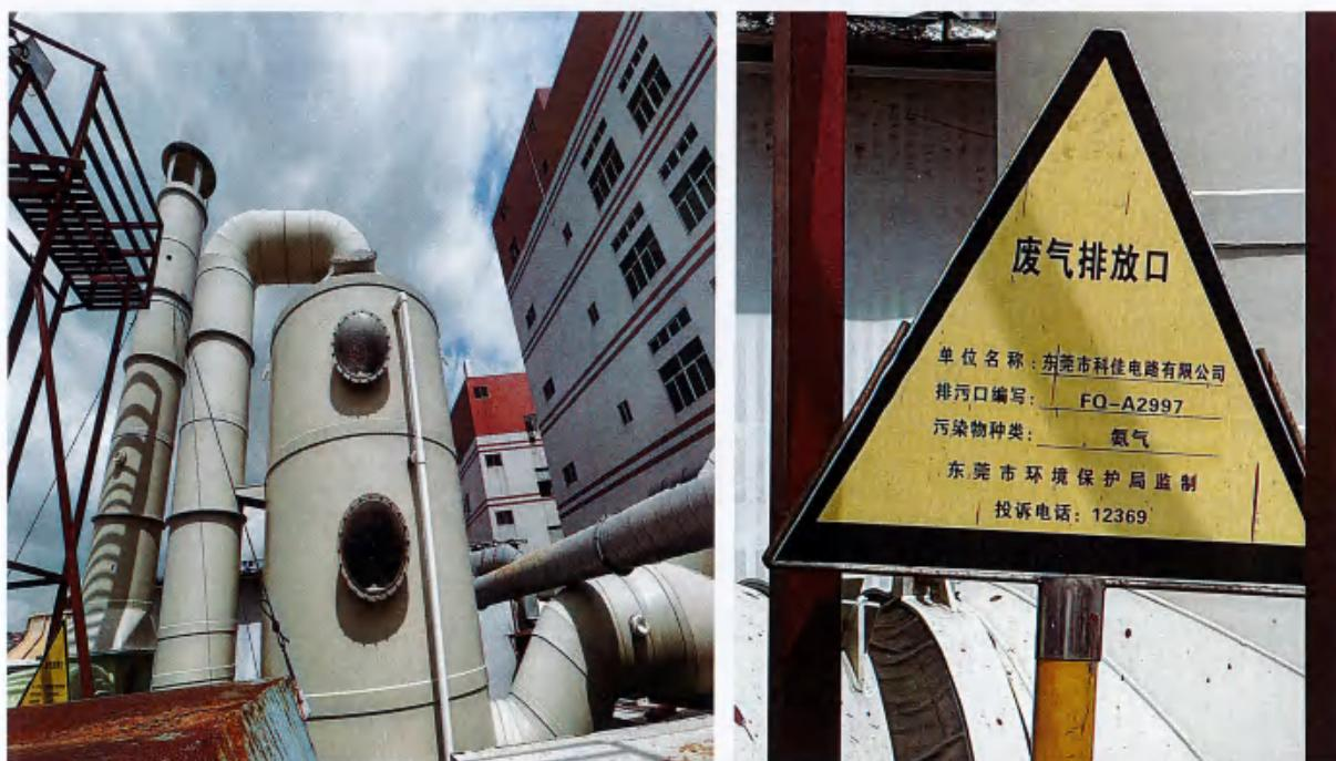
图 4-7 碱性蚀刻废气排放口 FQ-A2997 对应治理设施及标识牌
