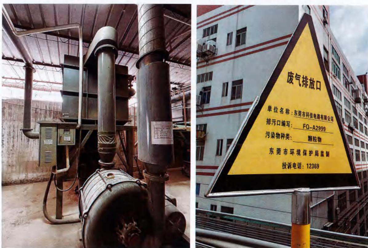
图 4-11 粉尘废气排放口 FQ-A2999 对应治理设施及标识牌
