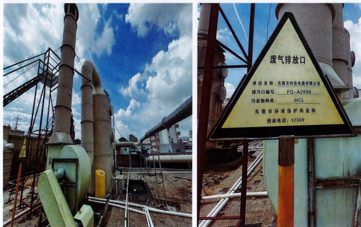
图 4-9 酸性蚀刻废气排放口 FQ-A2996 对应治理设施及标识牌
