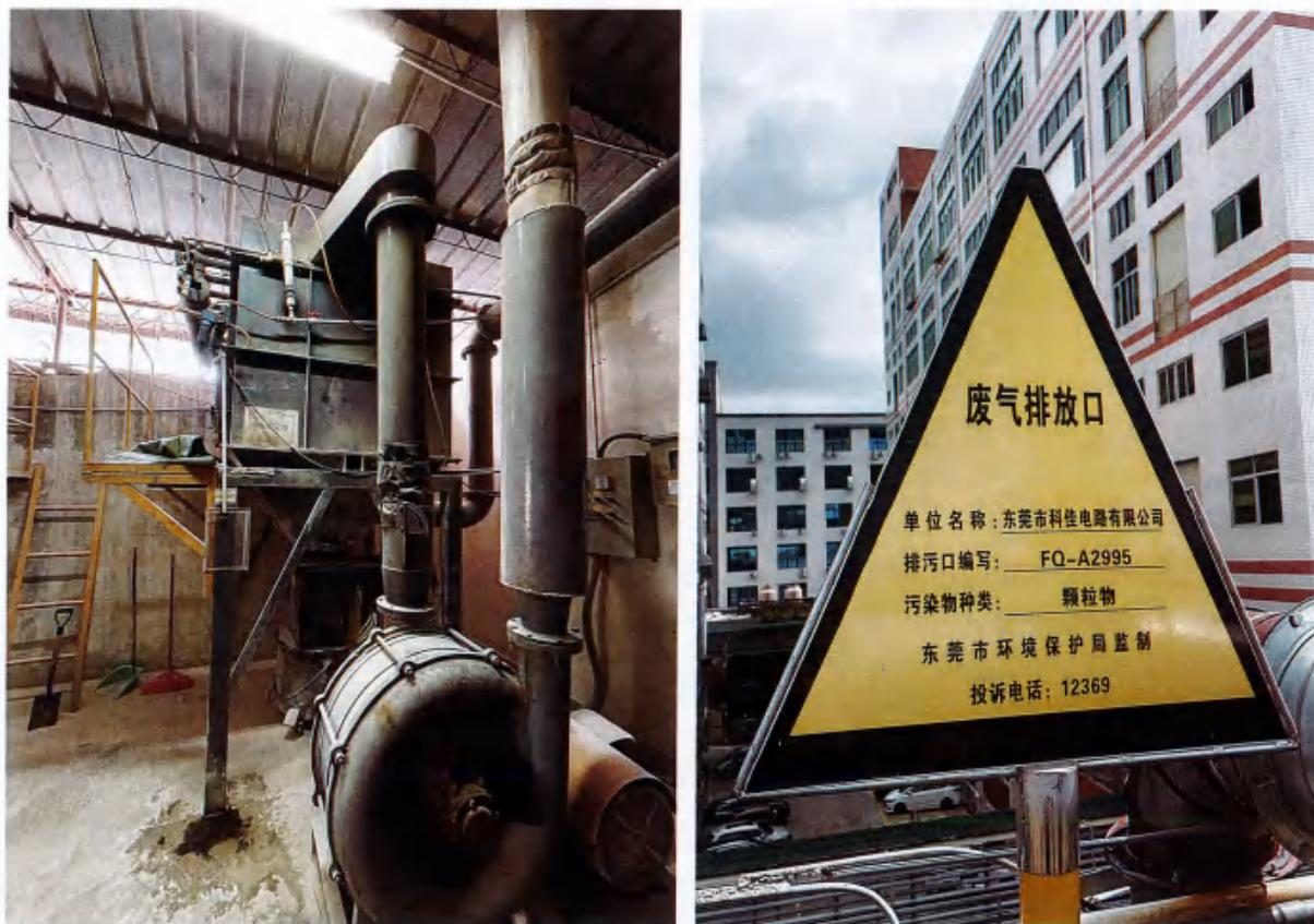
图 4-10 粉尘废气排放口 FQ-A2995 对应治理设施及标识牌
